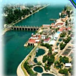
瀬田川洗堰およびバイパス水路
