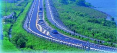
湖岸堤(堤防上部は県道として利用)とヨシ植栽
