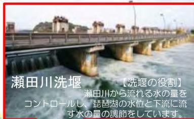
瀬田川洗堰 【洗堰の役割】瀬田川から流れる水の量をコントロールし、琵琶湖の水位と下流に流す水の量の調節をしています。
